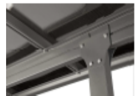
Piede sottotetto centrale
